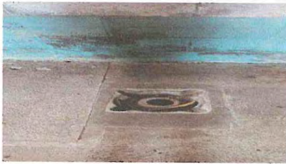
reparacion de tapaderas de caja parte del patio
