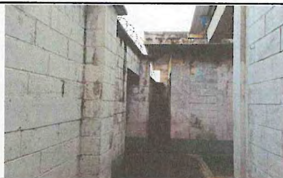
pintura en muro interior
