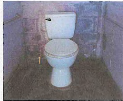
sustitucion de inodoro
